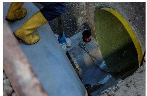
Alcune immagini dal cantiere di Viale delle Industrie – Monza Condotta ovoidale 1800x1200 mm, spessore 14 mm
